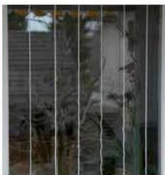
Bei Holzfenstern praktisch und günstig: Beidseitig an Rahmen je 1 Nagel einschlagen, Gummiband spannen und alle 10 cm eine dicke weisse Nylonsehnur anknüpfen.
